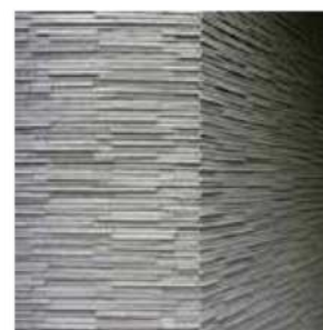
建築用廃材・外壁
